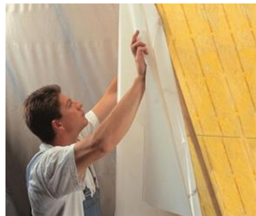
Aanbrengen van een dampscherm
