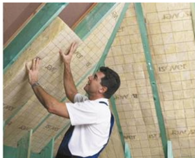
Plaatsing van dakisolatie met lambda-waarde 0,035 W/mK
