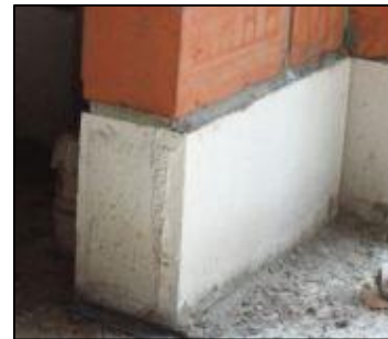
Aanzet binnenspouwblad op vloerplaat met Kimblok
