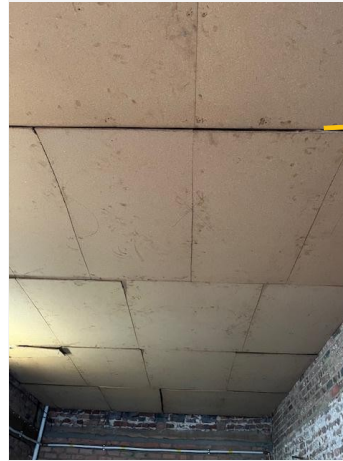
Afwerking binnenkant dak met vezelplaten
