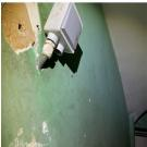
L'indice de protection contre les contacts directs des luminaires, socles de prises et/ou interrupteurs n'est pas suffisant - il faut placer des globes, des caches, des couvercles adaptés. (4.2.2)
