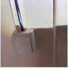
L'utilisation de douilles pour alimenter un point d'éclairage dans l'attente de l'appareil d'éclairage définitif n'est autorisée (4.2.4.3.a)
